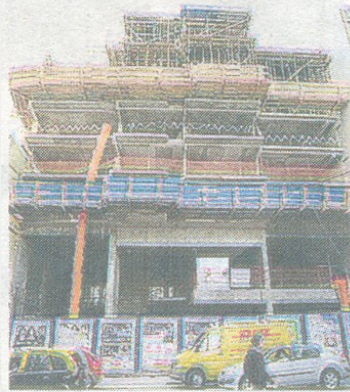
EDIFICIO EN CONSTRUCCION.
